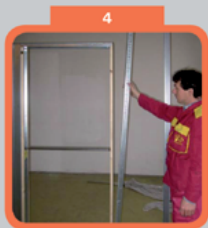
Монтаж на противоположната страна на конструкцията
