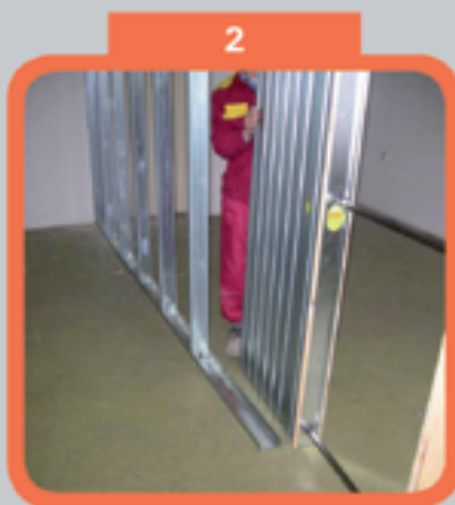
Полагане на строителната касета в долния ГК профил
