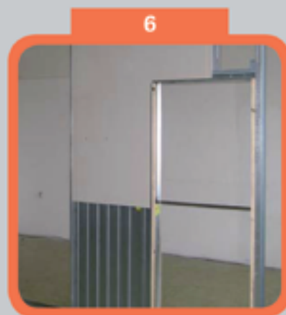
Покриване на касетата с ГК плоскости
