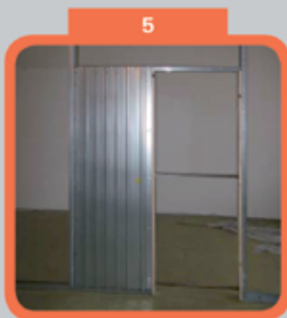
Разполагане и вграждане на касетата в конструкцията
