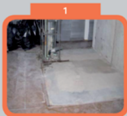
Подготовка на повърхността
