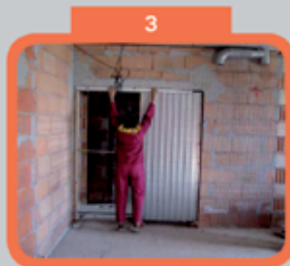
Хоризонтално нивелиране на строителната касета
