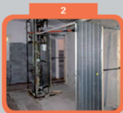
Изградена и нивелирана строителната касета
