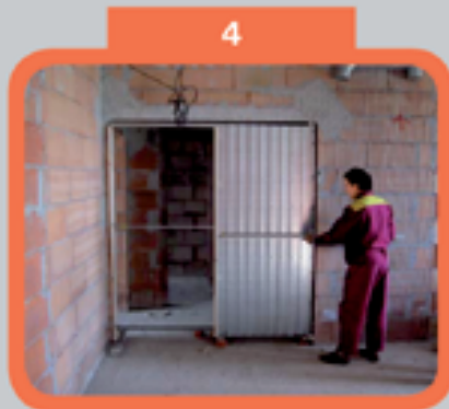
Вертикално нивелиране на строителната касета
