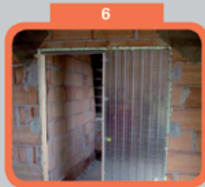
Касета, монтирана и фугирана с пена в строителния отвор
