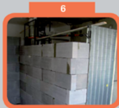
Зазидана касета в преградата (Внимание над касетата трябва да има носеща греда!)
