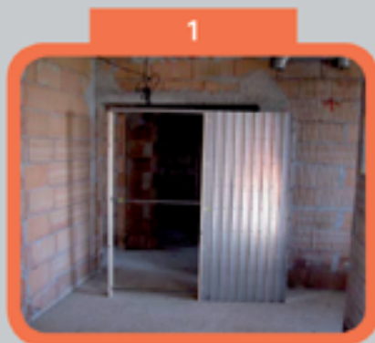
Сглобяване на касетата
