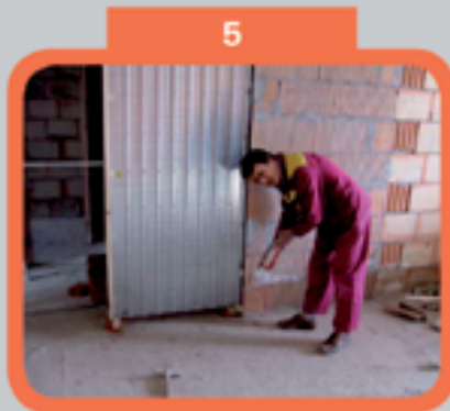
Запълване на захванатата касета с нискоекспандируема монтажна PU пена
