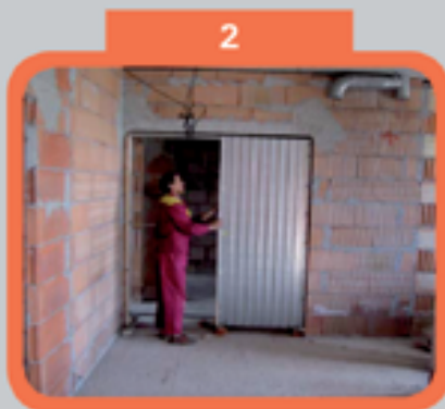
Полагане и наместване на строителната касета в строителния отвор
